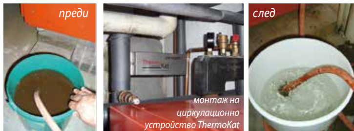
Калцитът е превърнат в арагонит след монтажа на AquaKat!
